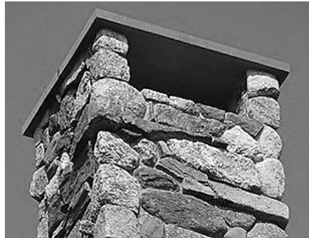
Stone Cap Chimney Top
